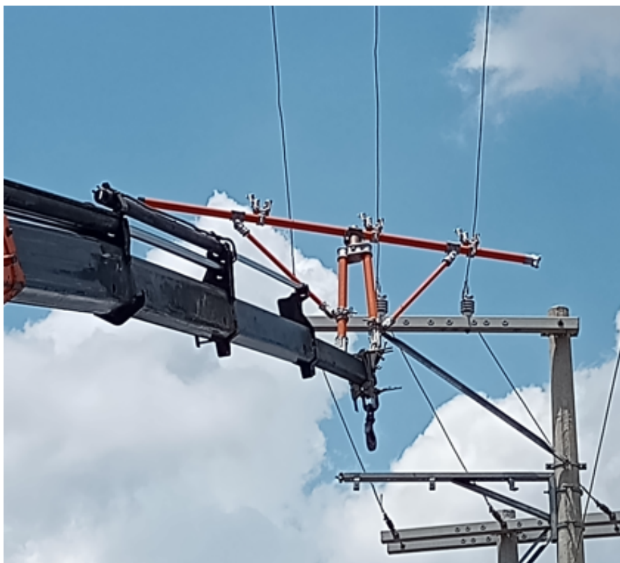
Figura 3 - Detalhe do suporte instalado na lança do guindauto.
