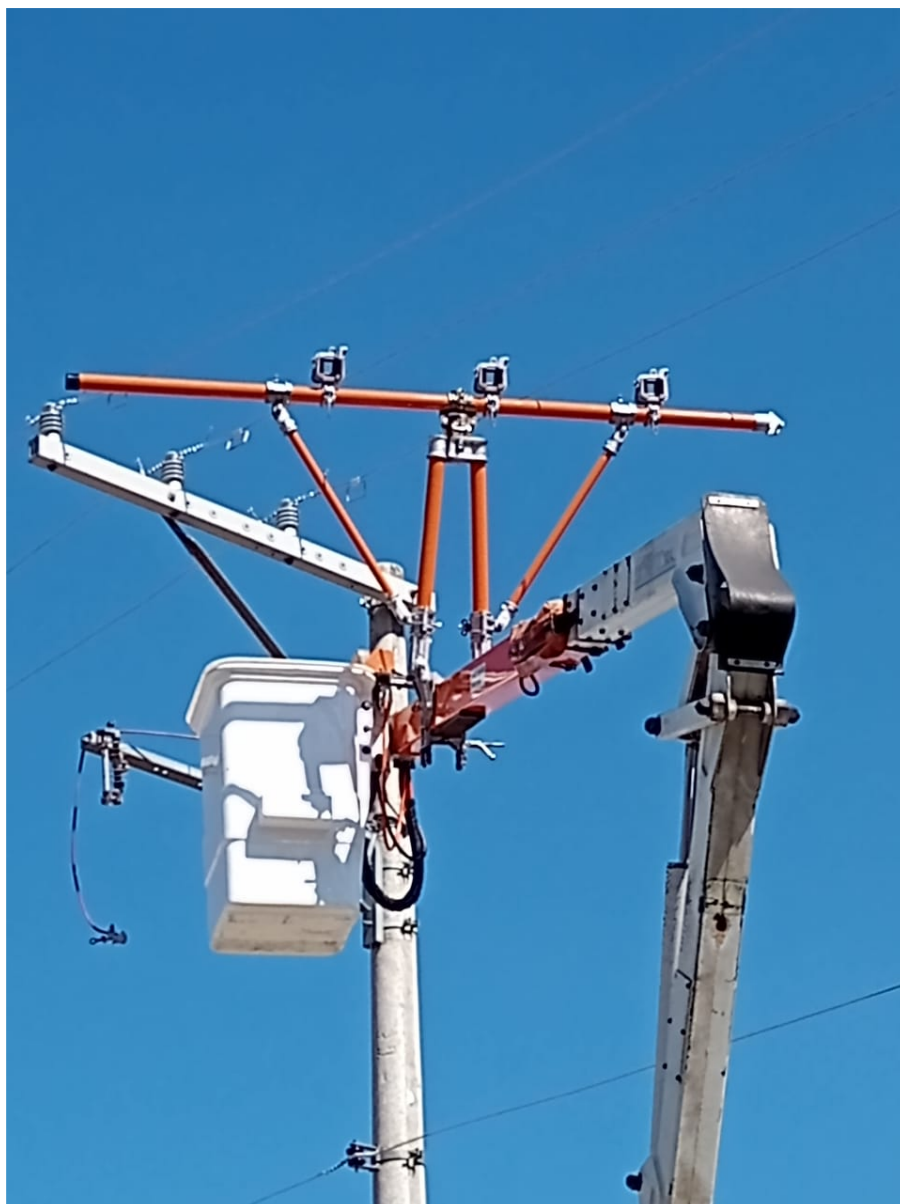
Figura 9 - Suporte instalado em braço/lança de cesta aérea.
